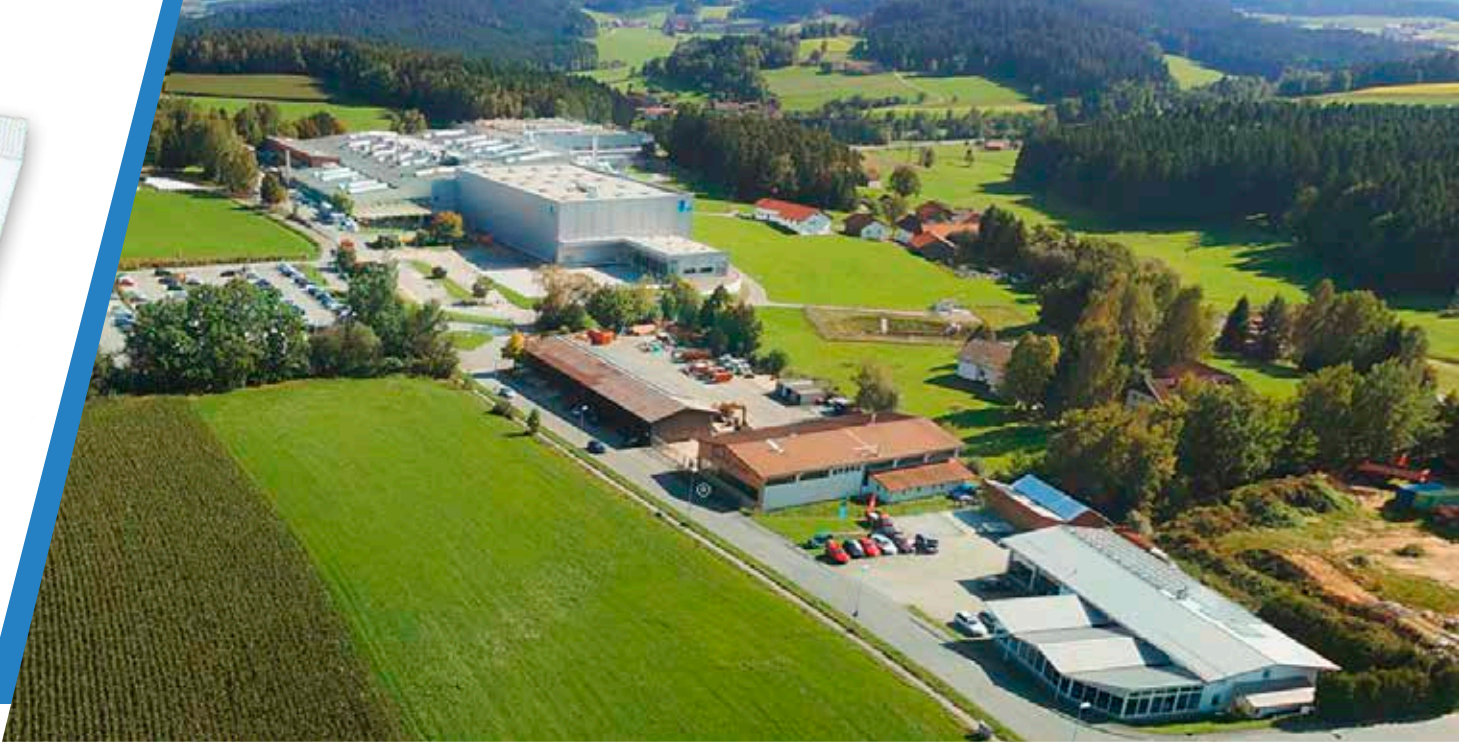
Οι εγκαταστάσεις της LINHARDT στο Viechtach, στην Κάτω Βαυαρία, βρισκονται σε ένα πανέμορφο καταπράσινο τοπίο. LINHARDT Group GmbH
