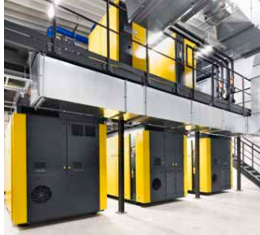
Εικόνα, αριστερά: Τεράστια φύλλα μεμβράνης παράγονται μέσα σε αυτούς τους πανύψηλους εξωθητές. Εικόνα, δεξιά: Ο νέος σταθμός πεπιεσμένου αέρα διαρθρώνεται σε δύο επίπεδα για εξοικονόμηση χώρου.
